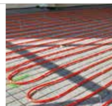
Průmyslové podlahové vytápění/chlazení Industry Mokrý systém
