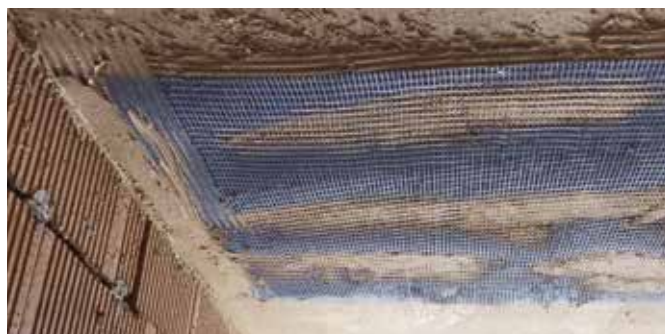
6. Inštalácia sklotextilnej výstuže
