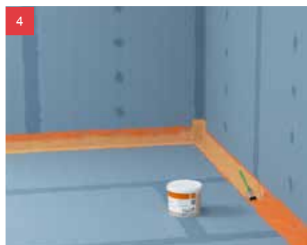
4 Tesniacu pásku pretrite tekutou fóliou fermacell® ihneď po pritlačení.
