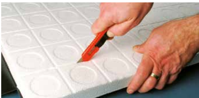
3. Na vytvorenie styku s presahom treba tvrdú vrchnú vrstvu nadvihnúť a nožom odrezat' izolačnú vrstvu.
