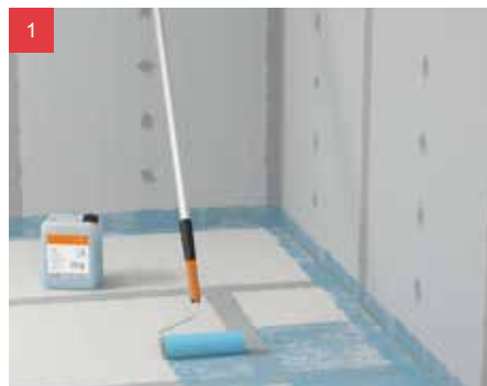
1 Na priľahlú plochu stien a podlahy naneste valčekom hĺbkovú penetráciu fermacell®.
