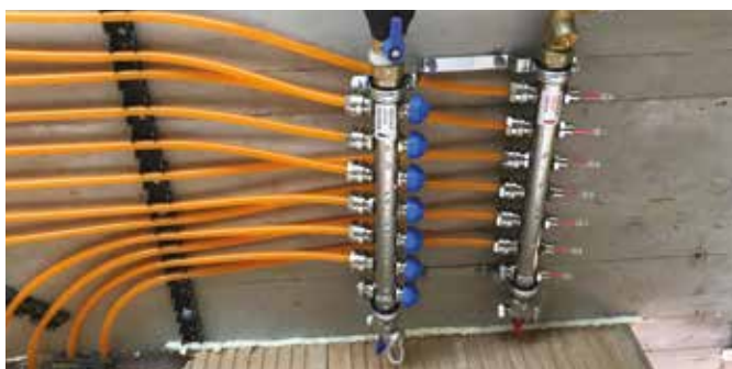
4. Montáž rozdeľovacej stanice
