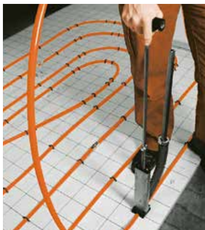
2. Po položení systé- mových pásov špirálové ukladanie rúrky
