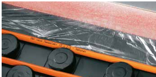
12. Vloženie fólie okrajových oddelovacích pásov pod okrajovú rúrku (nevyhnutné pri tekutých poteroch)!
