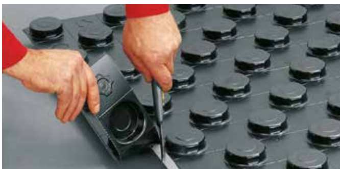
2. Odrezanie presahov vrchnej fólie orezávačom pred položením dosiek k stenám miestnosti
