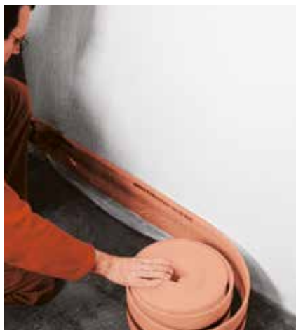
1. Pokladanie dilatačných pásov
