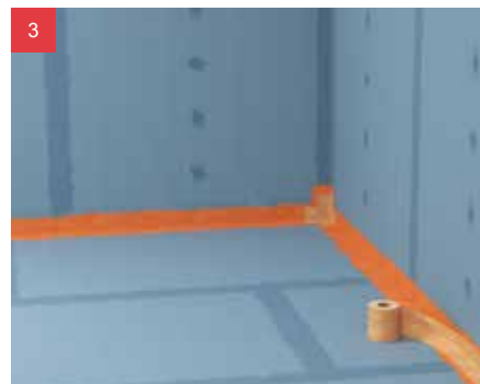
3 Zatlačte tesniacu pásku fermacell® do vlhkej tekutej fólie.
