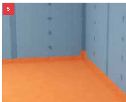
5 Celoplošné utesnenie povrchu v oblasti W1-I.
