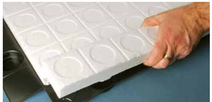
4. Odstránenie izolácie na vytvorenie presahu
