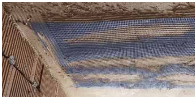
6. Instalace sklotextilní výztuže
