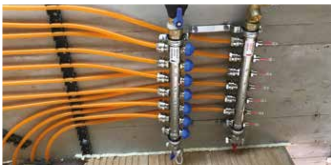
4. Montáž rozdělovače
