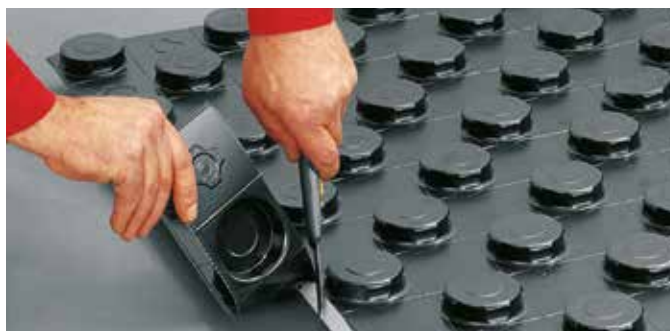
2. Odstranění přesahů tvrdé svrchní vrstvy nožem na koberce při ukládání ke stěnám místnosti
