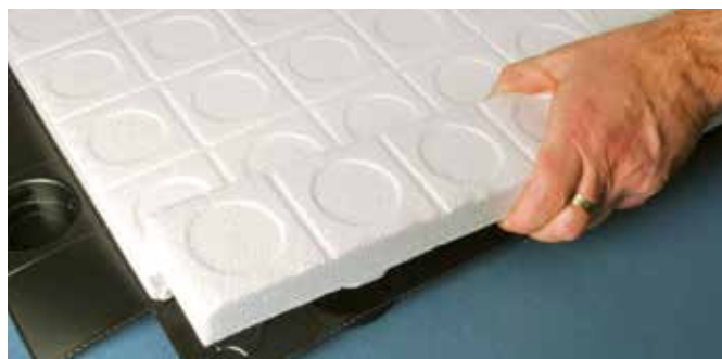
4. Odstranění izolační vrstvy pro vytvoření tvarového zámku
