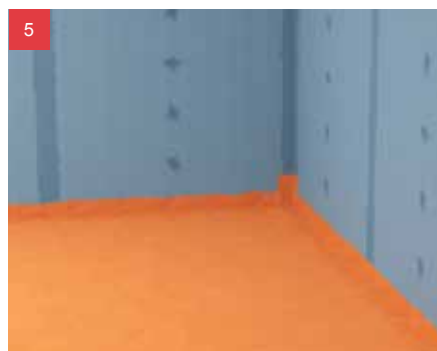
5 Celoplošné utěsnění povrchu v oblasti W1-I.
