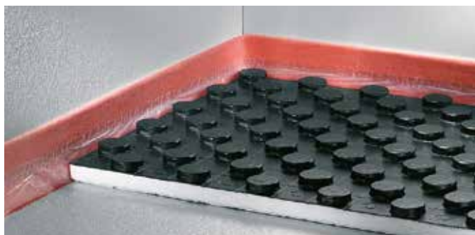
1. Ukládání dilatačního pásu
