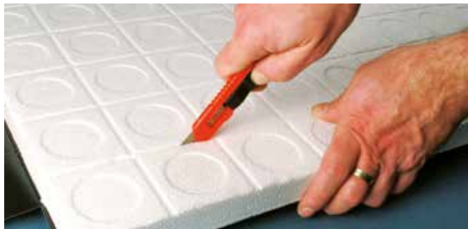
3. K vytvoření styků s přesahem je třeba tvrdou svrchní vrstvu zvednout a nožem na koberce odříznout izolační vrstvu
