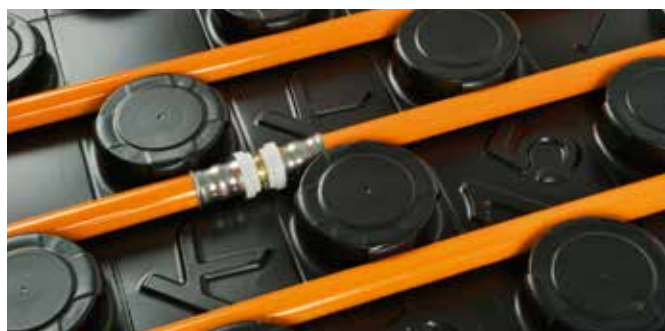
11. Lisovaný spoj v konstrukci podlahy
