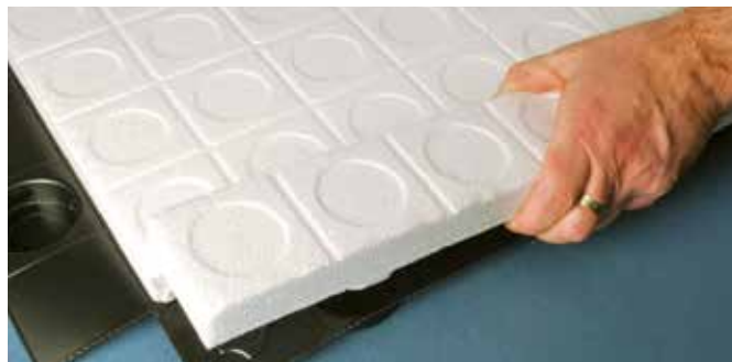
4. Odstránenie izolácie na vytvorenie presahu
