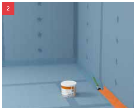
2 V rohu použite tekutú fóliu fermacell®.
