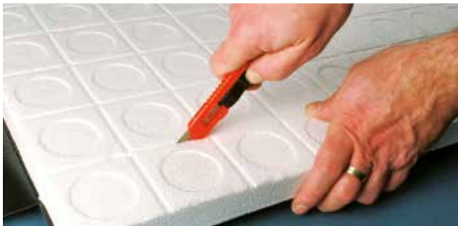
3. Na vytvorenie styku s presahom treba tvrdú vrchnú vrstvu nadvíhnuť a nožom odrezat' izolačnú vrstvu.
