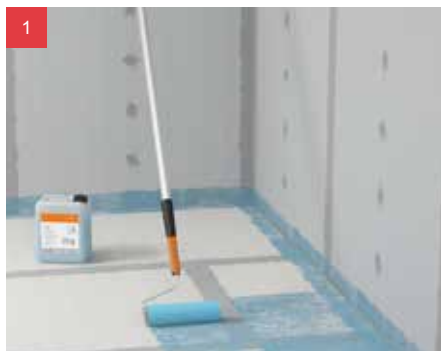
1 Na priahľú plochu stien a podlahy naneste valčekom hĺbkovú penetráciu fermacell®.
