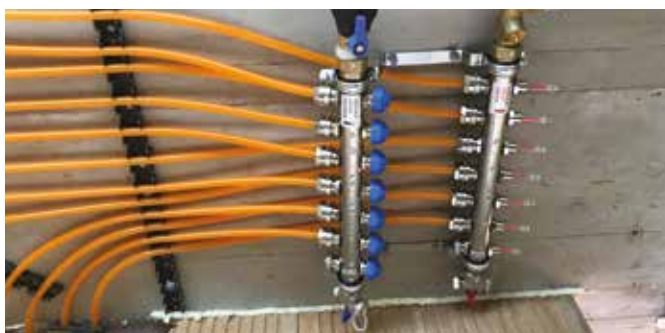
4. Montáž rozdeľovacej stanice
