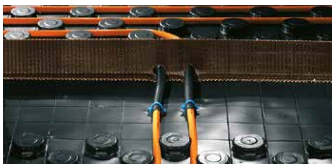
7. Ochranná rúrka, napr. pri prechode cez dvere!
