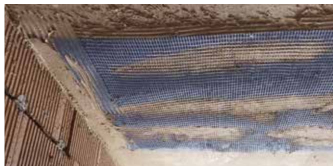
6. Inštalácia sklotextilnej výstuže
