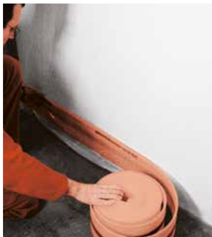
1. Pokladanie dilatačných pásov
