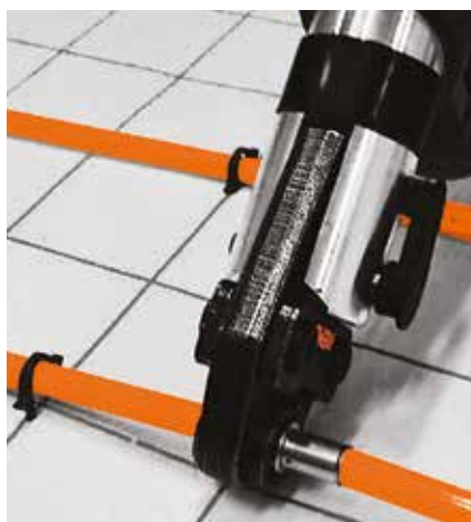
3. Spájanie rúrok lisovaným spojom
