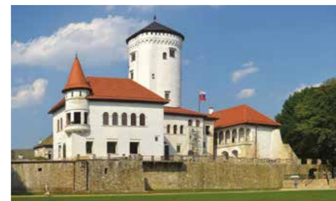
Budačinský zámok, Žilina (podlahové vykurovanie Gabotherm®)
