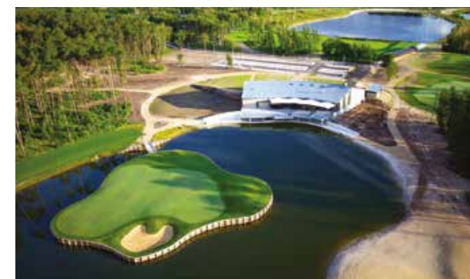
Golfový areál, Šajdíkové Humence (podlahové vykurovanie Gabotherm®, 700 m 2 )
