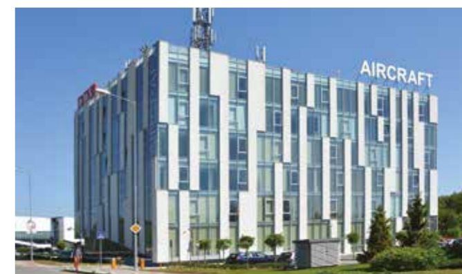
Polyfunkčný objekt AIRCRAFT, Bratislava (podlahové vykurovanie Gabotherm®, 1300 m 2 )
