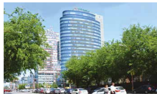
VUB centrála, Bratislava, Mlynské Nivy (podlahové vykurovanie Gabotherm®, 1 800 m 2 )
