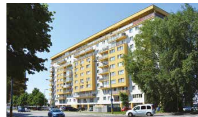
Polyfunkčný dom VAZEX, Bratislava (podlahové vykurovanie Gabotherm®, 7 600 m rúrky, rozvody vykurovania a vody)
