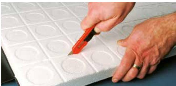
3. Na vytvorenie styku s presahom treba tvrdú vrchnú vrstvu nadvihnúť a nožom odrezat' izoláciu vrstvu.
