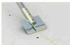
Zo škáry vytlačené lepidlo sa po jeho zaschnutí odstráni škrabkou na lepidlo FERMACELL, špachtľou alebo širokým dlátom.
