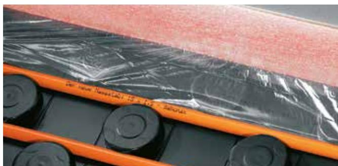
12. Vloženie fólie okrajových oddeľovacích pásov pod okrajovú rúrku (nevyhnutné pri tekutých poteroch)!
