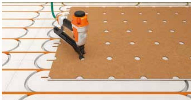
Montáž krycej dosky a mechanické upevnenie pomocou skrutiek alebo sponiek s použitím šablóny.
