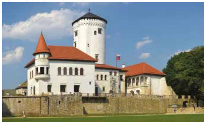
Budatínsky zámok, Žilina (podlahové vykurovanie Gabotherm®)
